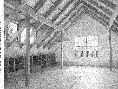
2階は屋根の構造用合板も現して用いられている
